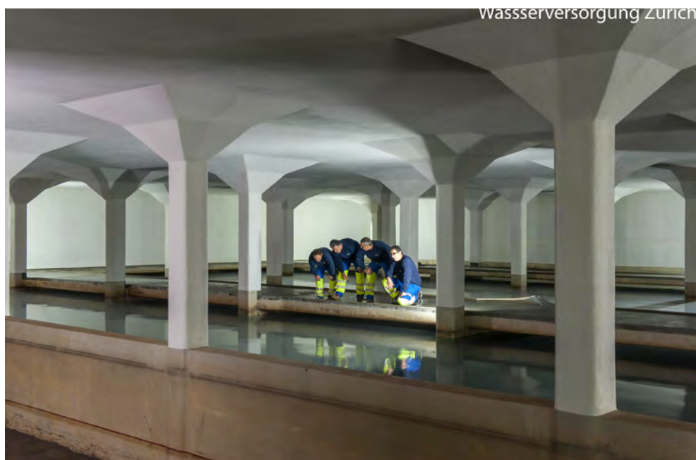
Zisterne der Wasserversorgung Zürich
